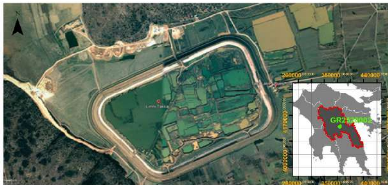
Σχήμα 1. Δορυφορική εικόνα του Google-Earth τον Δεκέμβριο του 2017, κατά την κατασκευή του ταμιευτήρα. Figure 1. Satellite image available on Google-Earth in December 2017, during the construction of the reservoir.
