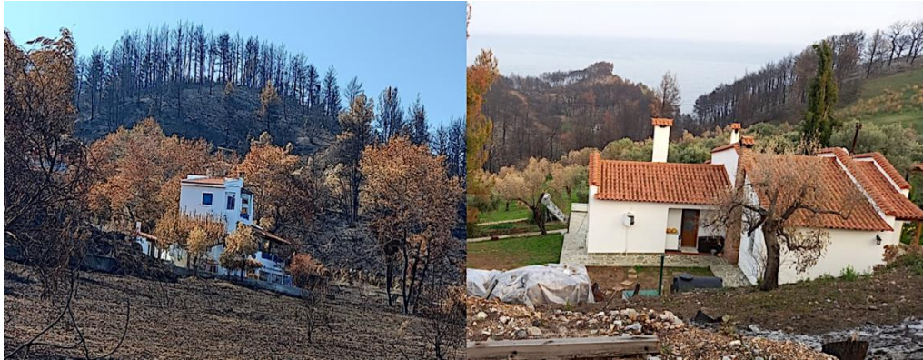
Σχήμα 1. Κατοικίες με μικρές ζημιές εξαιτίας των υλικών κατασκευής και της ύπαρξης χώρου άμυνας Figure 1. Houses with minor damages due to the construction material and existence of defensible space
