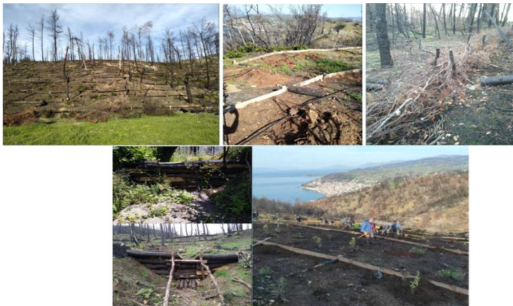
Εικόνα 5. Απόψεις των αντιδιαβρωτικών έργων Picture 5. Photos of the anti-erosion constructions
